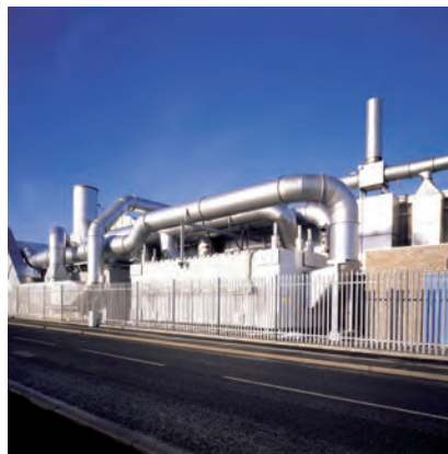
Industrial Fan Control
